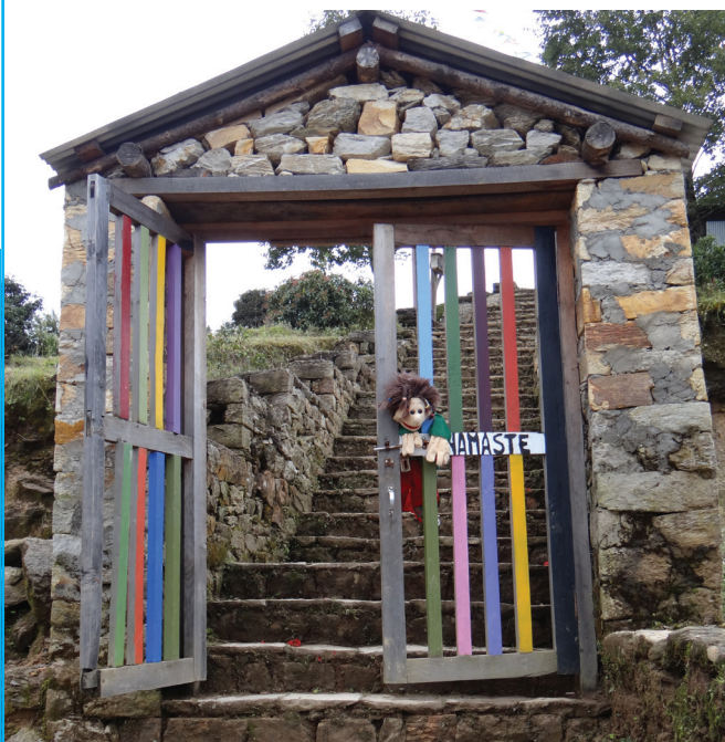
De nieuw aangelegde trap naar de school
